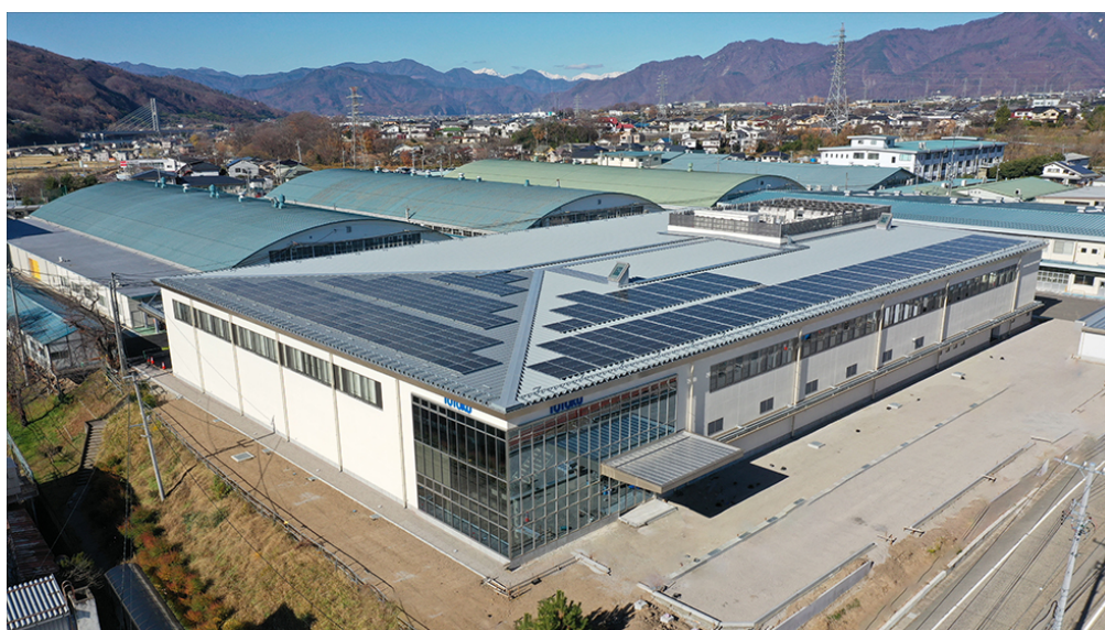
(新工場外観写真)
